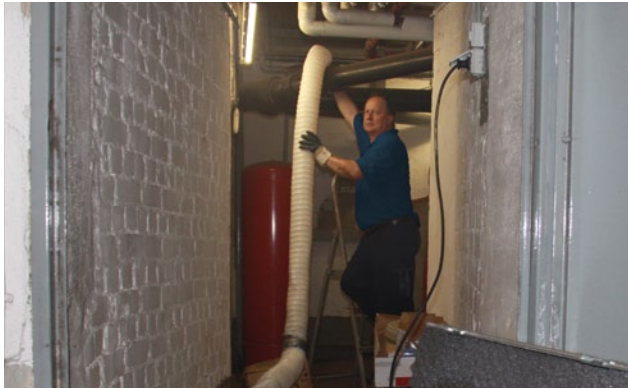
Nebelzufuhr ins Rohrsystem
