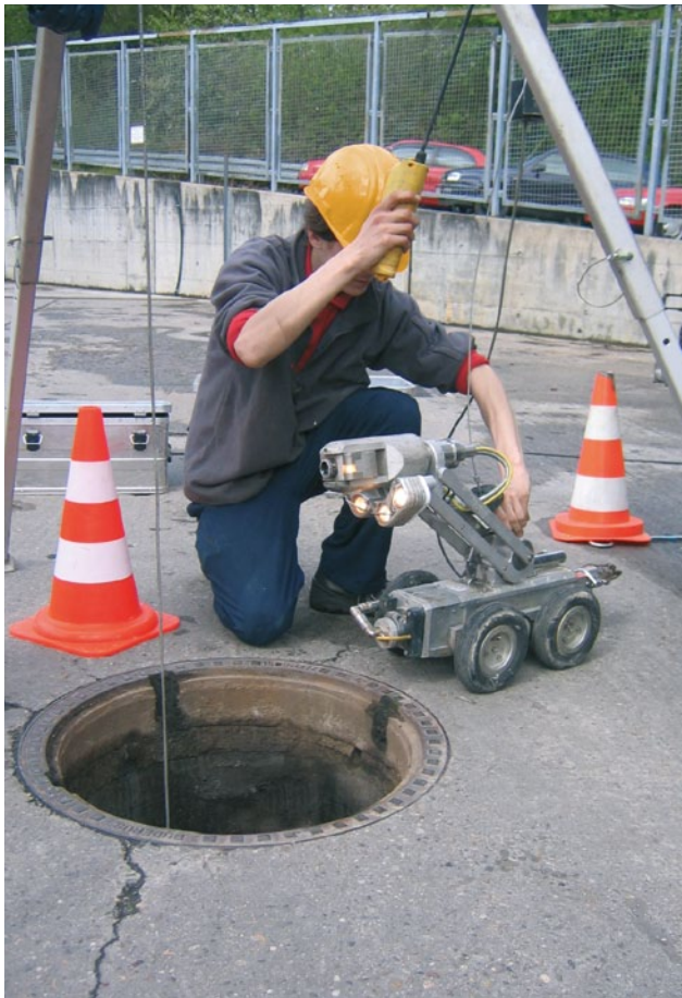
Vorbereitung zum Einsatz eines Kamerawagens
