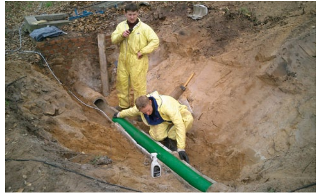
Vorbereitung für die Rohrreparatur
