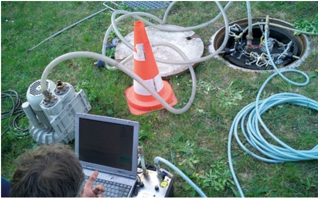
Schachtprüfung mit Vakuum
